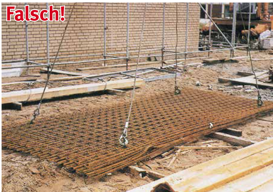
Bild 16-5: Einhängen in die Umschnürung ist lebensgefährlich!
