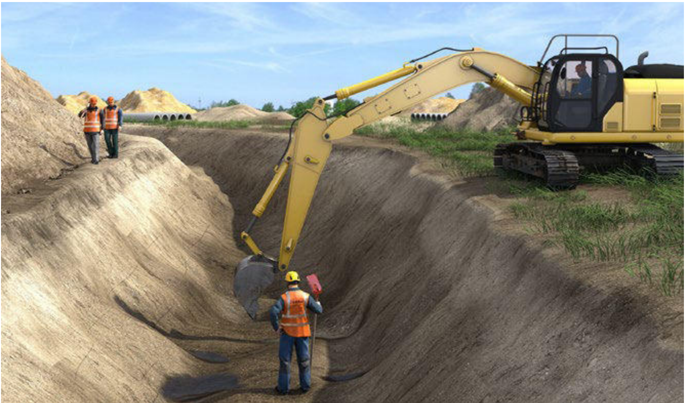
Abb. 105 Schutzstreifen am Baugruben/Grabenrand
