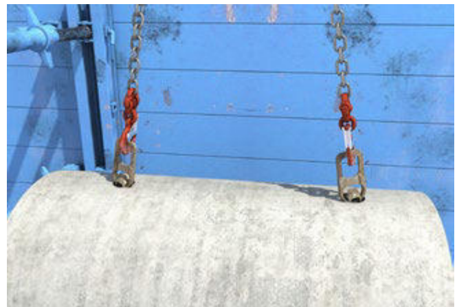
Abb. 86 Formschlüssig wirkende Lastaufnahmemittel (Kugelpfanne)
