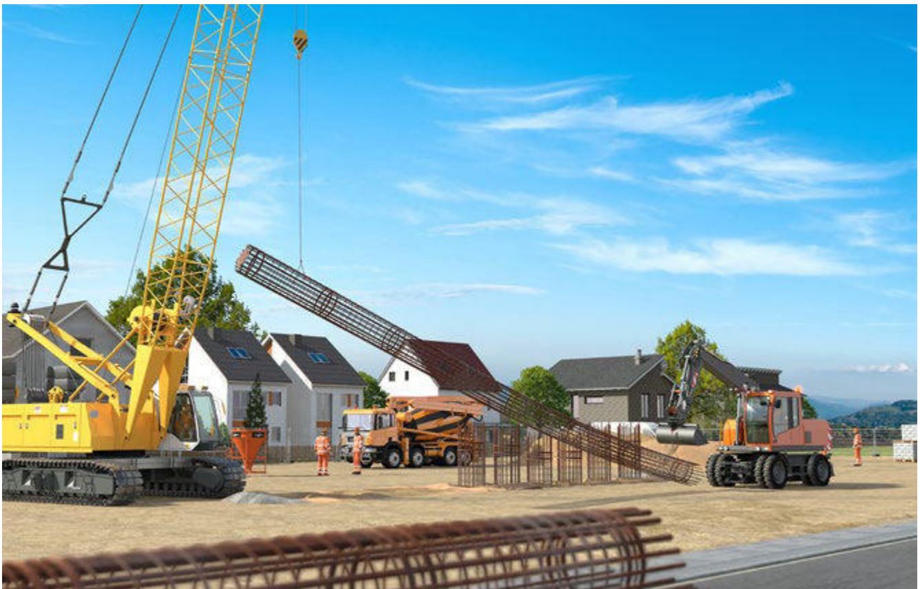
Abb. 128 Heben eines Bewehrungskorbes
