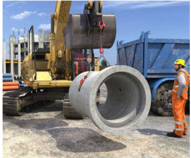
Abb. 87 Transport einer formschlüssig angeschlagenen Last
