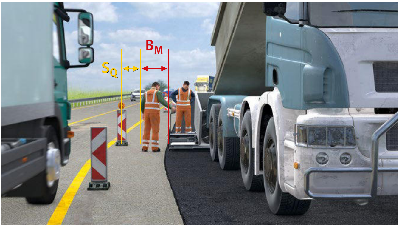
Abb. 101 Erforderlicher Arbeitsraum ( B_M ) und Sicherheitsabstand ( S_Q )
