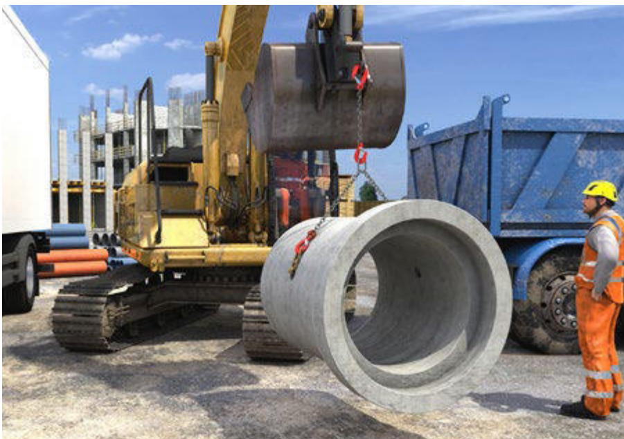
Abb. 59 Transport einer formschlüssig angeschlagenen Last
