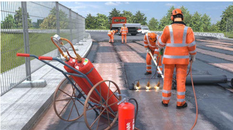
Abb. 35 Arbeiten mit Handbrennern
