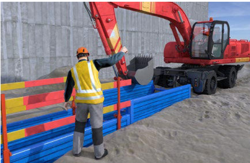
Abb. 113 Absturzsicherung am Verbau
