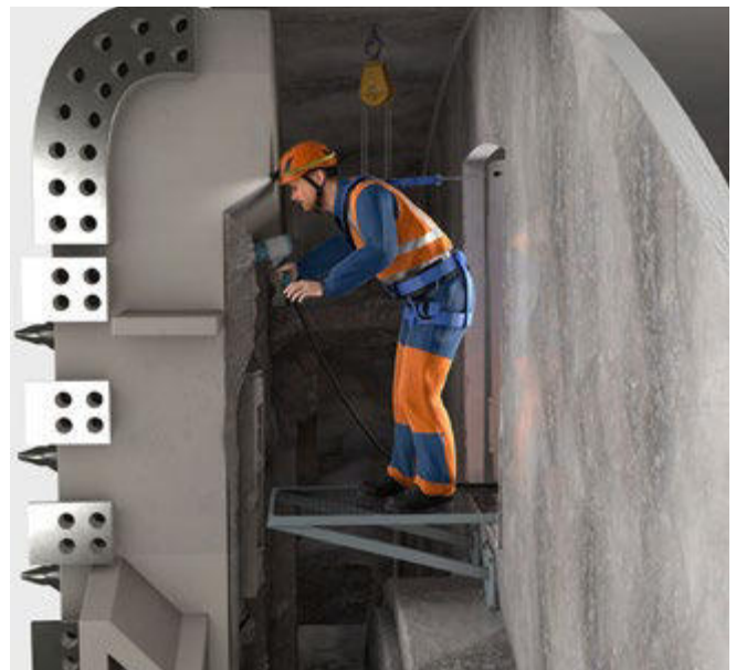
Abb. 143 Arbeitsbühne und PSA beim Werkzeugwechsel
