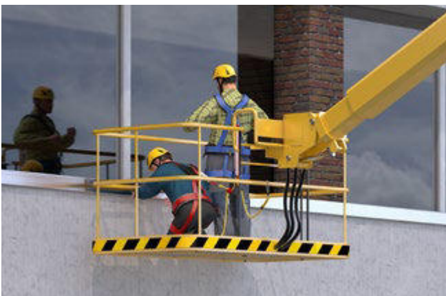
Abb. 89 Auffanggurt mit vorderer/hinterer Auffangöse und längenverstellbares (max. 1,80 m) Verbindungsmittel mit Falldämpfer
