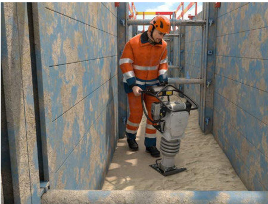
Abb. 94 Verdichtungsarbeiten mit einem Akku betriebenen Stampfer
