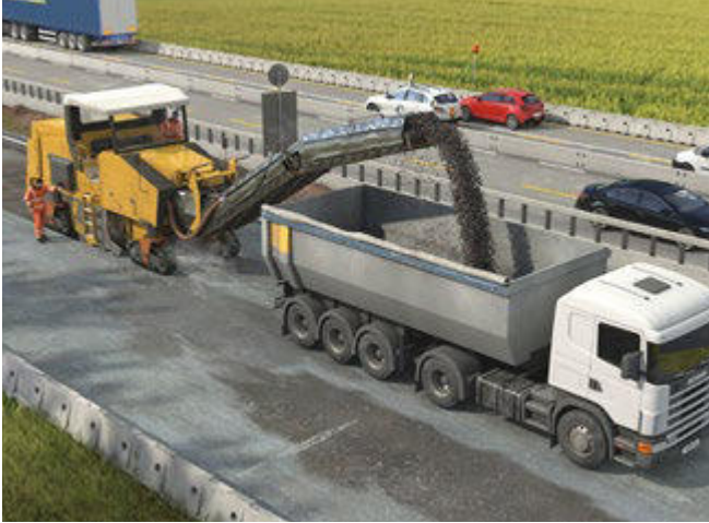
Abb. 103 Großfräse mit Absaugung
