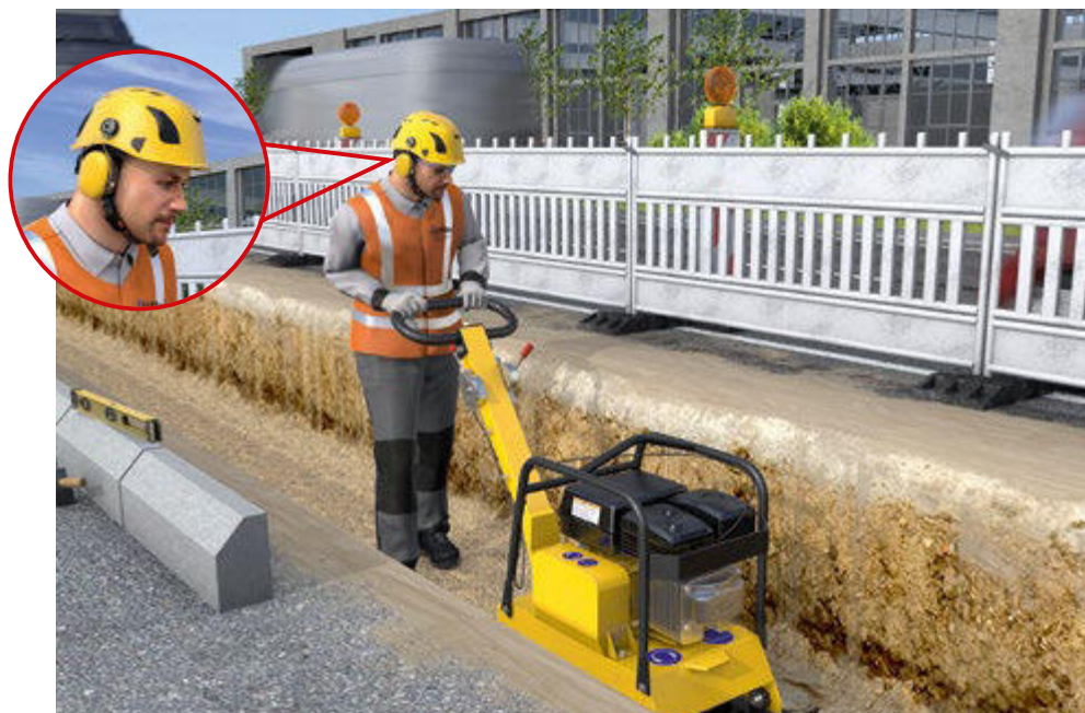
Abb. 55 Verdichtungsarbeiten mit geeignetem Gehörschutz
