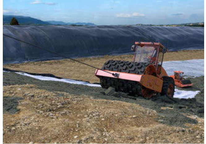
Abb. 78 Einsatz auf Böschungen
