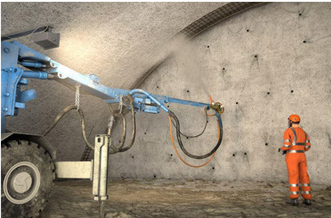
Abb. 140 Einsatz von Naßspritzbeton und Manipulator
