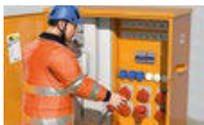
Abb. 28 Verschließbarer Baustromverteiler mit 30 mA und 500 mA Fehlerstrom-Schutzeinrichtungen
