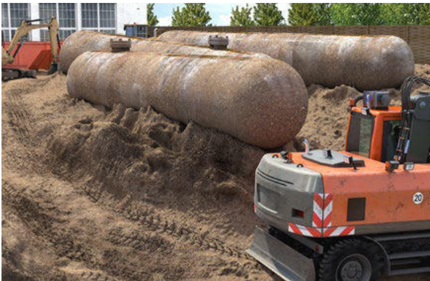
Abb. 17 Erdarbeiten in kontaminierten Bereichen
