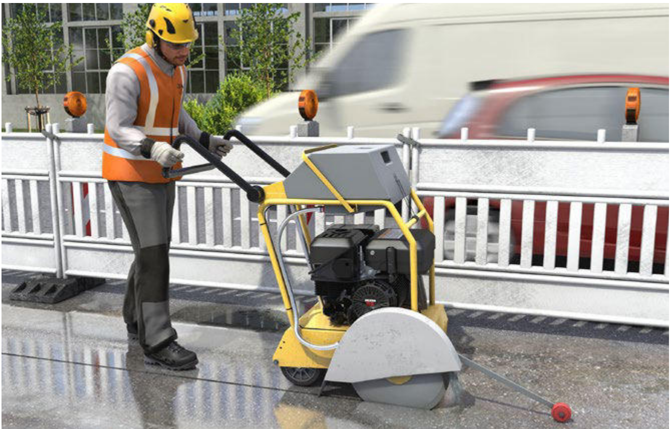
Abb. 13 Staubminimierung durch Nassschneiden
