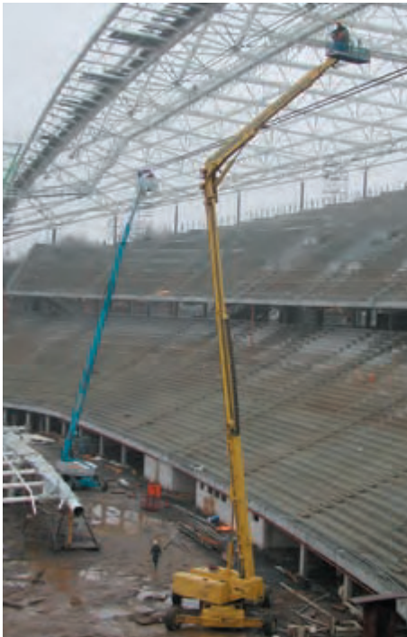
Bild 6-2: Hubarbeitsbühne im Baustelleneinsatz
