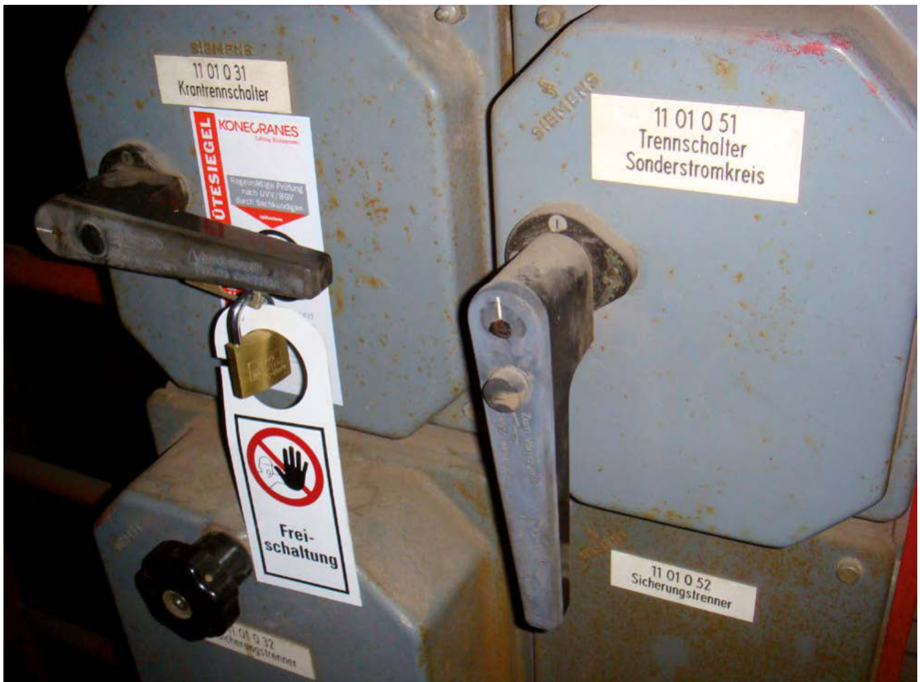
Bild 8-1: Der Krantrennschalter ist ausgeschaltet und durch ein Vorhängeschloss gegen das irrtümliche oder unbefugte Einschalten gesichert
