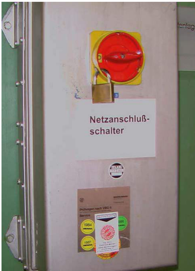
Bild 7-2: Der Kranführer schaltet den Netzanschlussschalter aus
