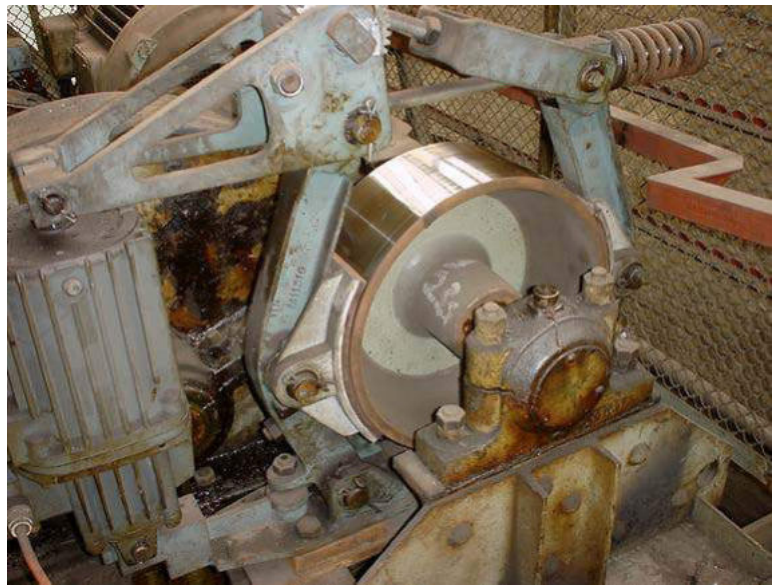
Bild 4-4: Inaugenscheinnahme einer Trommelbremse
