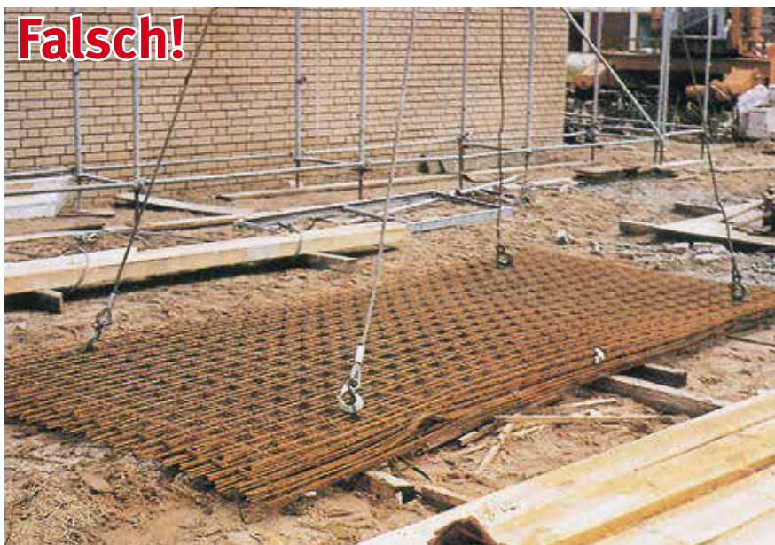
Bild 16-5: Einhängen in die Umschnürung ist lebensgefährlich!
