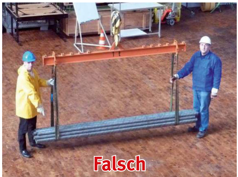
Bild 5-15: Beine der Anschläger befinden sich im Gefahrenbereich
