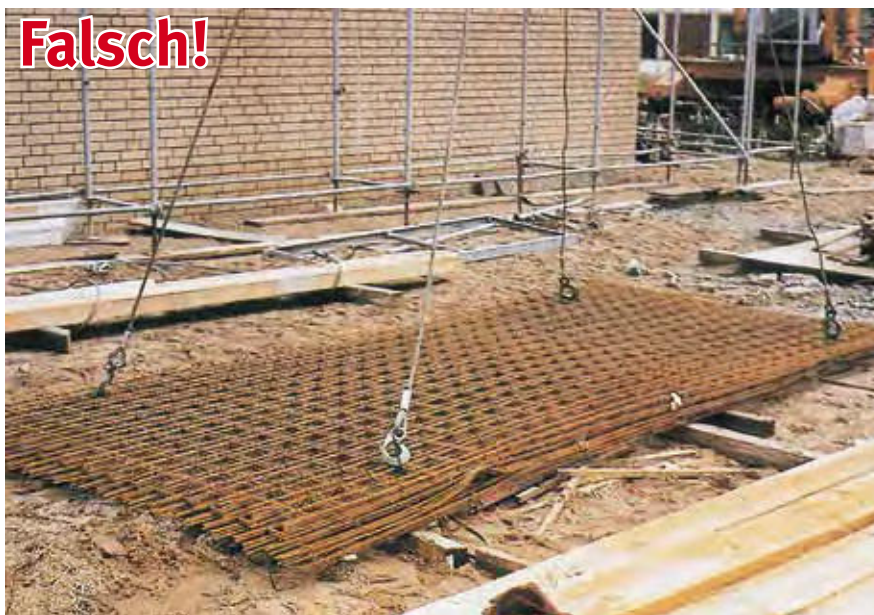
Bild 16-5: Einhängen in die Umschnürung ist lebensgefährlich!
