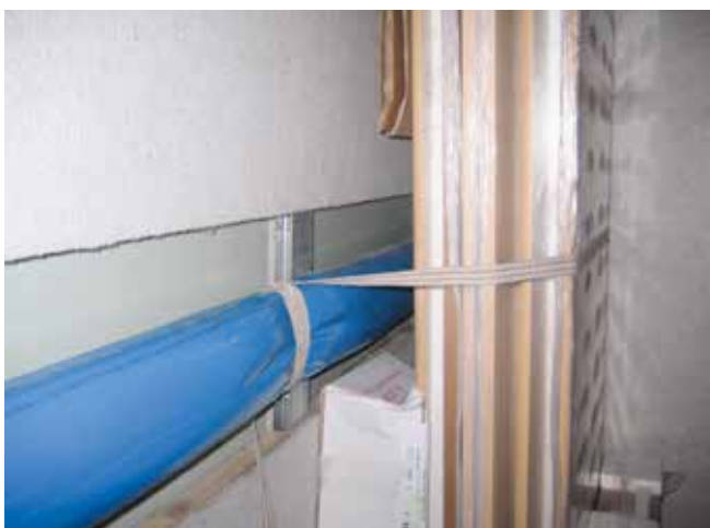
Abb. 10-50 Durch Umreifen gut gesichert: kleinere Partien
