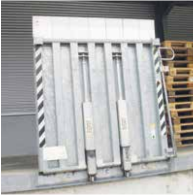
Abb. 2-20 Handbetätigte Ladebrücke
