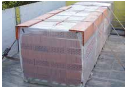
Abb. 7-49 Ladungssicherung durch Niederzurren
