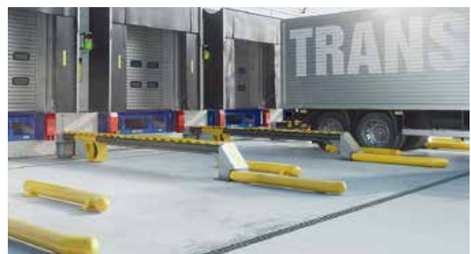
Abb. 2-16 Hat der Lkw die Beladestelle erreicht, schwenkt ein Blockierarm selbsttätig zwischen Rad und Schutzblech des Lkw und legt sich mit einer leichten Rückwärtsbewegung an diesen an.
