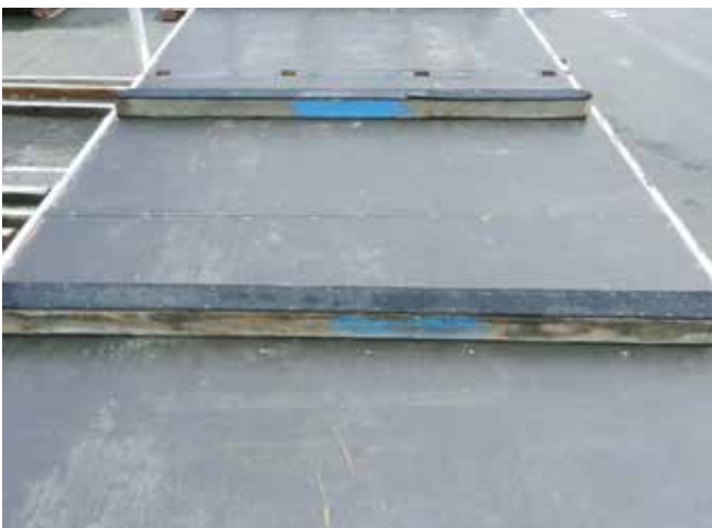
Abb. 10-89 Anti-Rutsch-Balken
