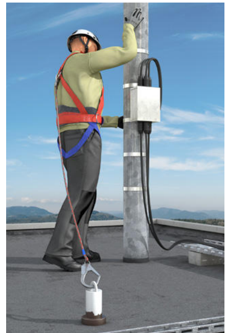
Abb. 17 Beispiel für ein Rückhaltesystem mit fester Länge
