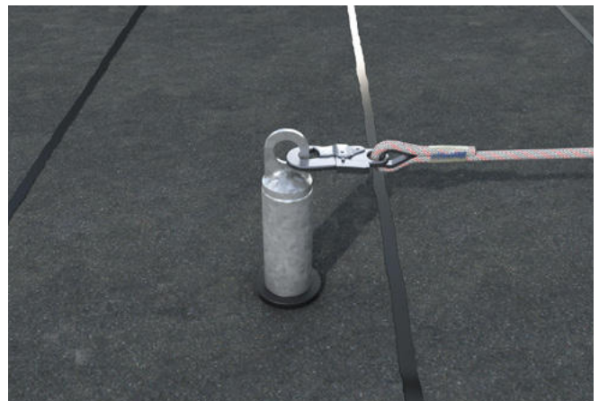
Abb. 57 Beispiel einer Anschlageinrichtung, die dauerhaft am Bauwerk befestigt ist (Einzelanschlagnagel-Stahlrohrstütze).
