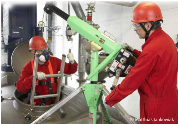
Abb. 5 Rettungshubgerät der Klasse B
