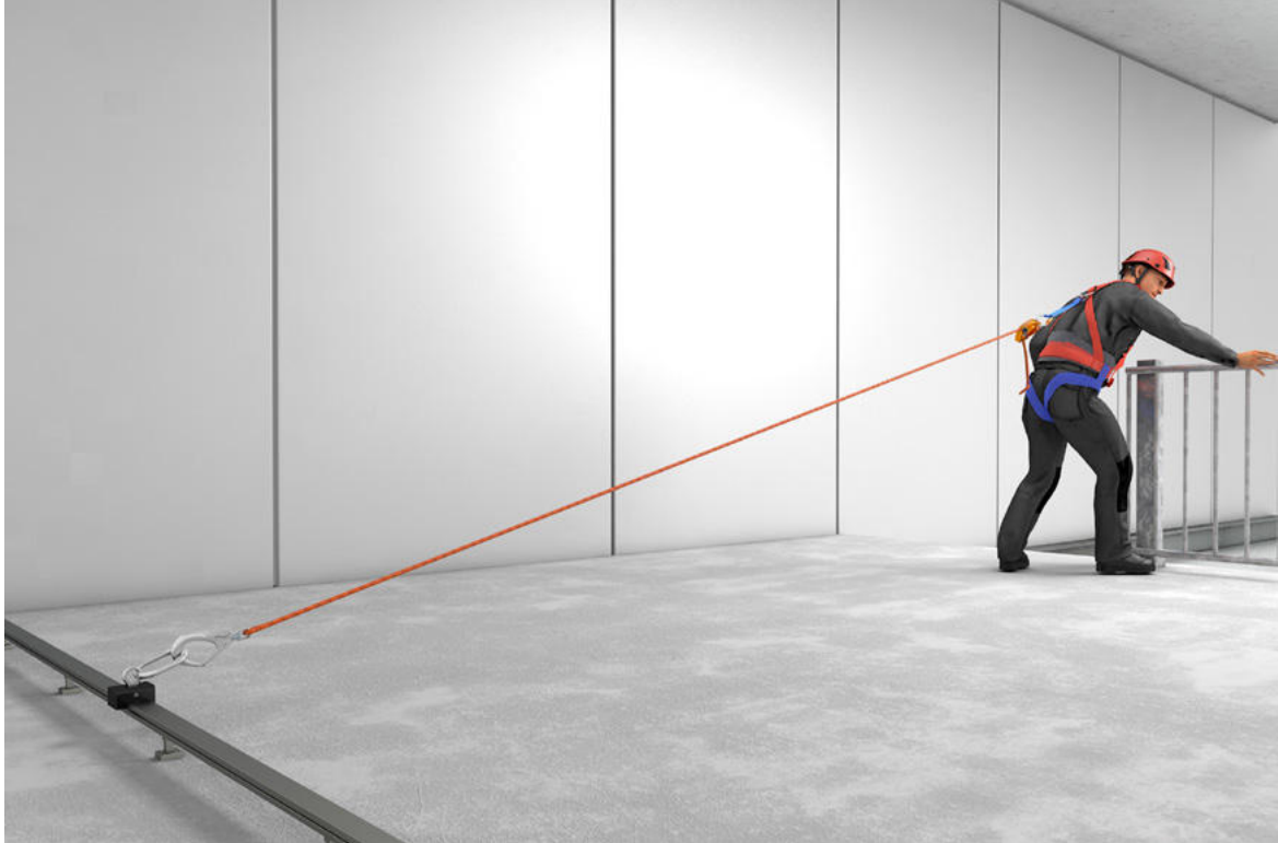
Abb. 68 Beispiel für eine nicht dauerhaft befestigte Anschlageneinrichtung vom Typ D DIN EN 795 (Schiene mit mobilen Anschlagpunkt)
