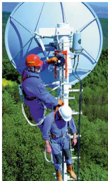
Abb. 8 Abseilgerät mit integrierter Hubeinrichtung
