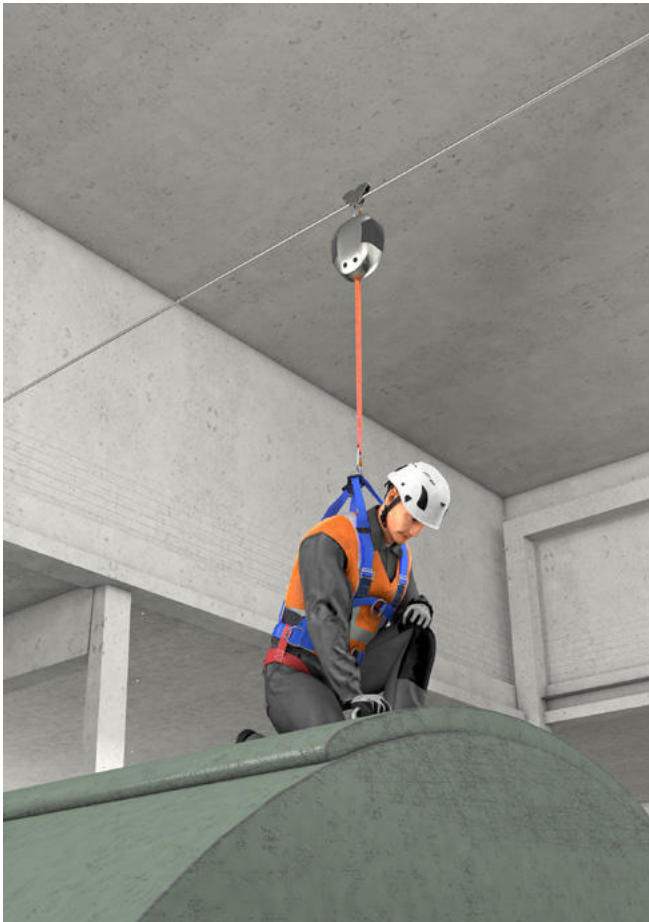
Abb. 70 Beispiel für eine dauerhaft befestigte Anschlag-einrichtung mit horizontalem Seil
