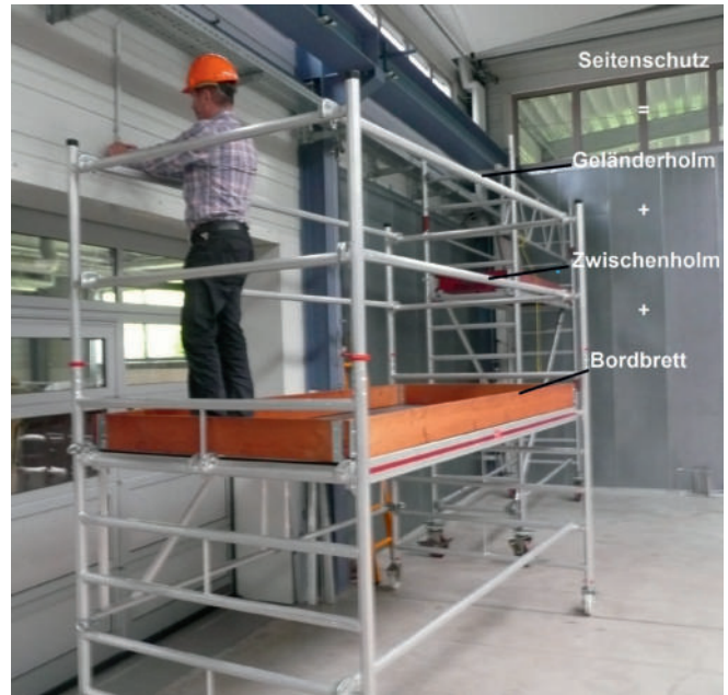
Bild 7-1a: Absturzsicherung – dreiteiliger Seitenschutz
